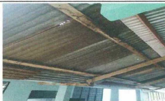
Foto 2: Se observa el deterioro de las laminas del corredor. Módulo 2
